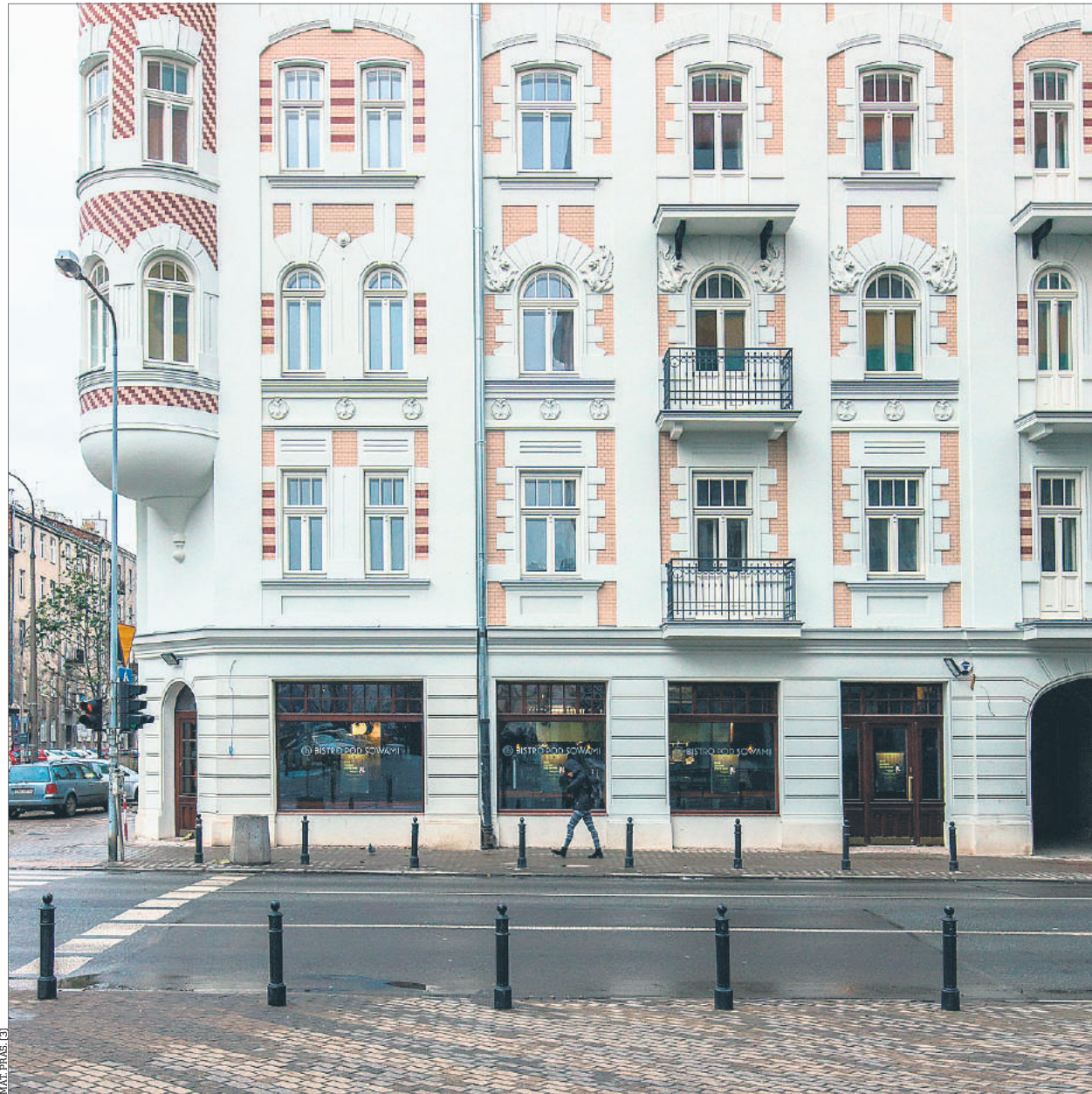
♦ Po latach prac remontowych budynek odzyskał dawną świetność.
